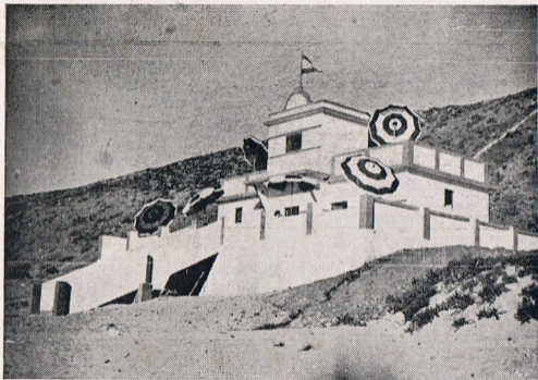
La caseta de baños en la playa, concurrida la mayor parte del año.
